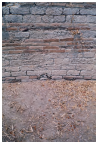
Εικόνα 11: Στόμιο αγωγού εκκένωσης λάσπης ομβρίων του εσωτερικού καναλιού καθίζησης.
